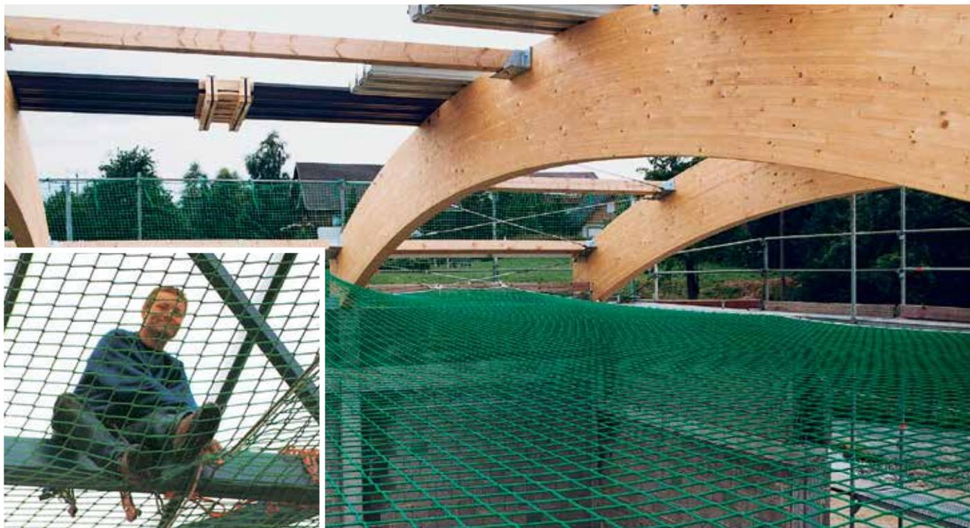
**Auffangnetze EN 1263-1, Schutznetztyp S** (Netz mit Randseil), **quadratische** Maschenanordnung, ringsum mit Randseil 12 mm ( 30 kN), Energieaufnahme ca. 4,4 KJ (Netztyp A2), GS-Prüfbescheinigung 03100001/3100004.
